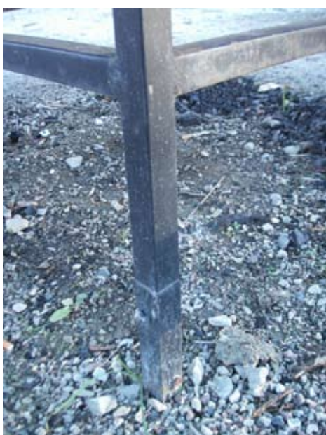
Benens infästning i inbjudna stål
